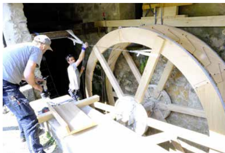
Die Zimmerleute Roland Krüsi und Reto Friemel montieren am neuen Wasserrad die 30 Schaufelbretter.
