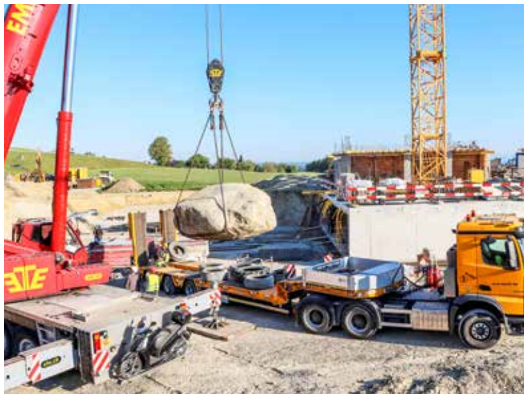
Der Felsbrocken wird auf der Baustelle Dorfwiese Berg SG verladen. Die Kosten für den Umzug nach Roggwil werden auf rund 10 000 Franken geschätzt.
