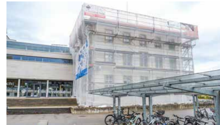
Im Schulhaus Reben 4 sind die Erneuerungsarbeiten in vollem Gange.
