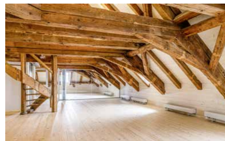
Im frisch ausgebauten Dachstock wird das imposante Balkenkonstrukt sichtbar.
