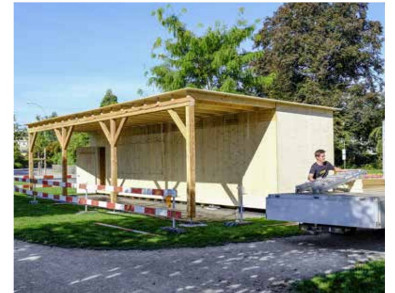
Noch am Mittwoch, 24. August, liefen die Aufbauarbeiten an der Zwischennutzung «Seeliebi». «Heute werde ich damit fertig sein, dann muss aber noch der Dachdecker ran», wie ein Arbeiter der Kaufmann Oberholzer AG erzählt.
