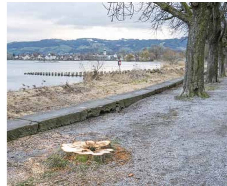
Eine Lücke in der Allee, doch in der Mitte des Baumstrunks sind die faulen Stellen deutlich erkennbar. Der Baum stellte ein Sicherheitsrisiko dar. /g
