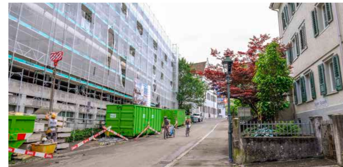
Kein Ausweichen: Atelier und Wohnhaus von Keramik-Künstler Bruno Feurer befinden sich direkt gegenüber der ZIK-Baustelle.
