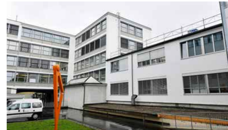
Die LC Systems hat im ZIK im Haus «Zum See 1» die ganze erste Etage gemietet, wo die Umbauarbeiten bis Mitte September abgeschlossen sein sollen.
