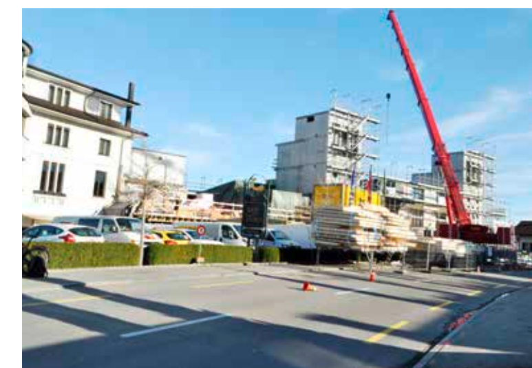
Das Viersterne-Superior-Hotel Bad Horn erhält einen neuen Ostflügel. Die 42 grosszügigen Gästezimmer werden als Fertigbauelemente per Kran eingesetzt.
