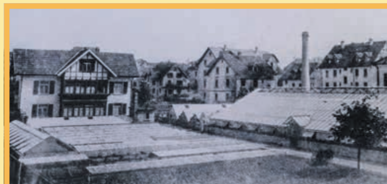
Die Anlagen der Gärtnerei, wie sie in den 1920er-Jahren ausgesehen haben.
