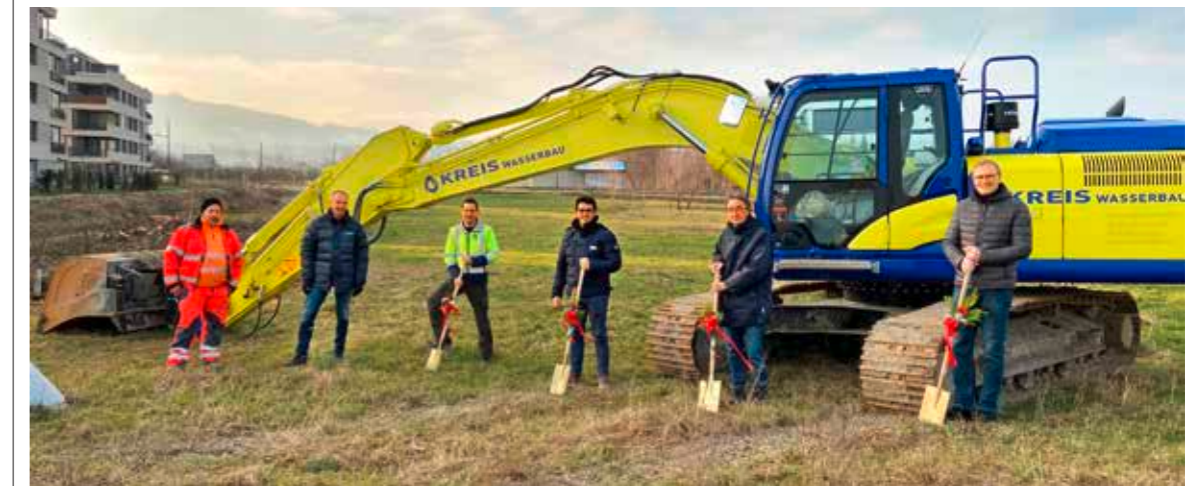
Beim Baustart letzten Montag: Horns Gemeindepräsident Thomas Fehr (rechts) freut sich mit dem verantwortlichen Ingenieur sowie Vertretern der Strabag AG und der Kreis Wasserbau AG, dass es losgeht.
