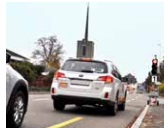
Seestrasse Horn bei der Kirche: Warten am Baustellen-Lichtsignal.
