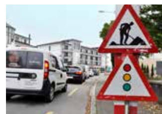
Seestrasse Horn beim Hotel «Bad Horn»: Warten am Baustellen-Lichtsignal.
