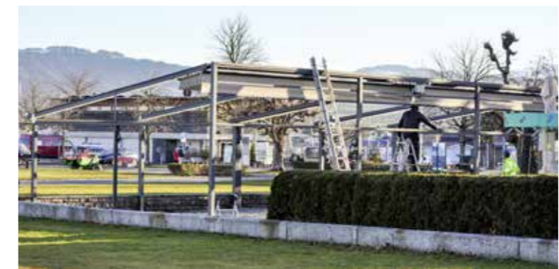
Abbau einer Bausünde: Pergola Nord beim Hotel-Restaurant Rotes Kreuz.
