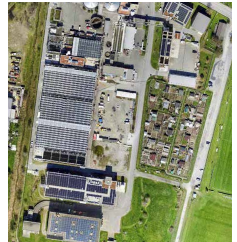
Mehr als eine Kläranlage – auf dem Gelände der ARA Morgental befinden sich neben den Wasserstrassen Photovoltaik-Anlagen und Gasspeicher. z.V.g.
