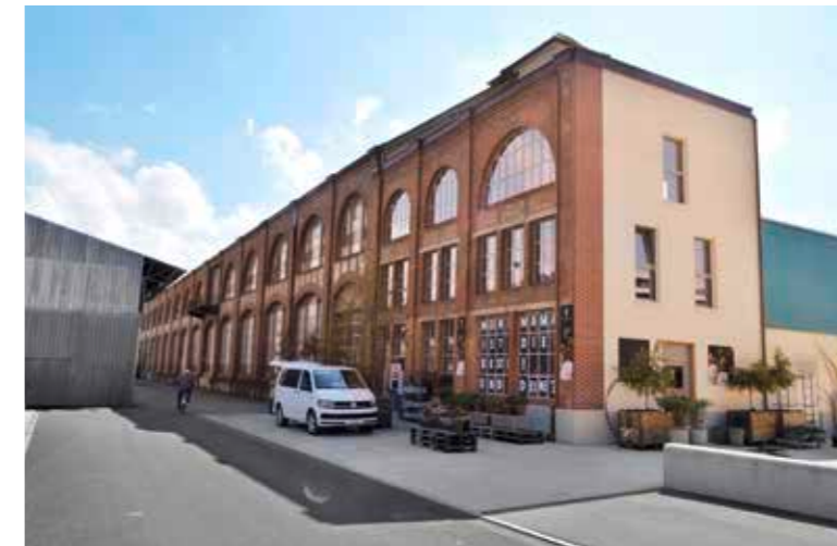
Die Webmaschinenhalle im WerkZwei in Arbon: Der Kanton Thurgau will diese der Firma HRS für rund eine Million Franken abkaufen.
