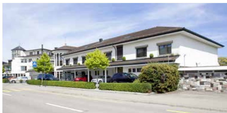
Der bestehende Ostflügel vom Hotel Bad Horn wird abgebrochen und durch einen Neubau ersetzt.
