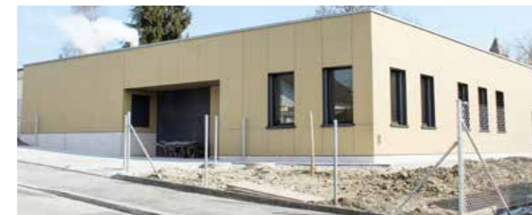
Das Arboner Friedhofwerkgebäude kurz nach seiner Fertigstellung 2018.
