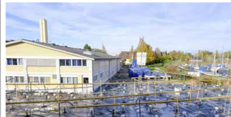
Aktuell wird auf dem Gelände von Reto Peterhans noch saniert. lg
