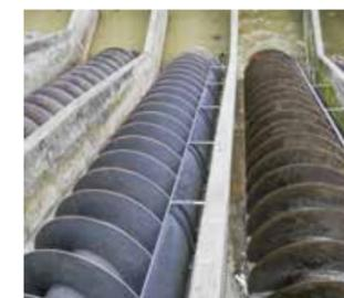
Im Einlaufhebewerk wird das Abwasser für die Reinigung angehoben. *lg*
