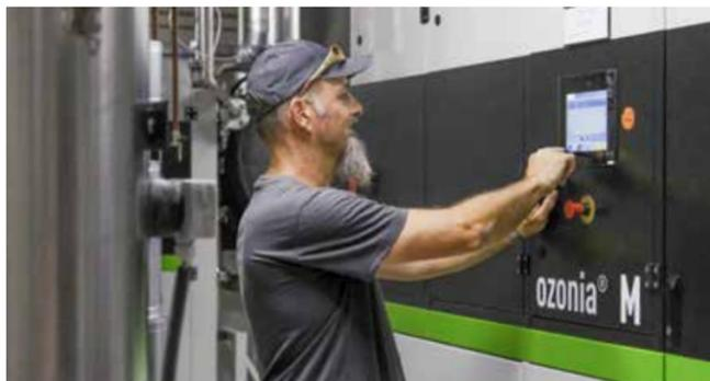
Im Ozongenerator vor Klärwerkfachmann Christian Eberle wird Sauerstoff mit Elektrizität zu Ozon umgeformt, um Mikroverunreinigungen zu eliminieren. *lg*
