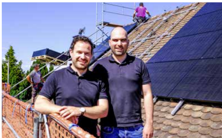
Martin Mäder (l.) und Ivan Fust auf dem Dach eines Kunden, bei dem aktuell eine PV-Anlage installiert wird.
