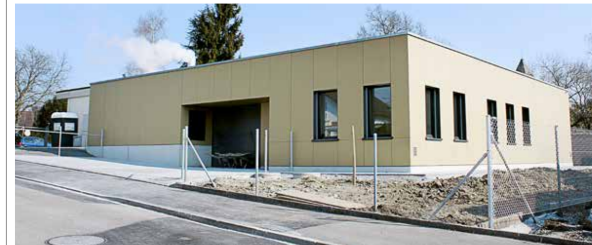
Das Friedhof-Werkgebäude Arbon Ende Februar 2018
