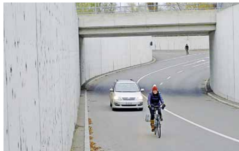
Beispiel aus dem 25 Positionen umfassenden Dossier «Schwachstellen Veloinfrastruktur Stadt Arbon»: Eine für den Langsamverkehr getrennte, sichere Bahnunterführung wurde im über 50 Mio. Franken teuren NLK-Projekt nicht berücksichtigt.
