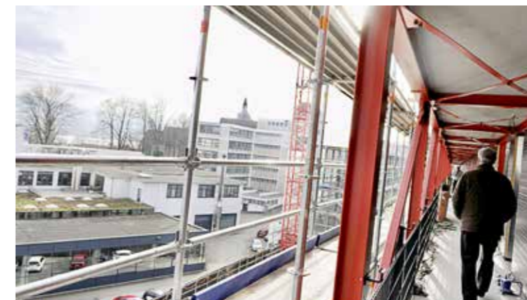
Blick ins Werk1 zum Städtli hin. Rechts der Aussenflur zu den Wohnungen.
