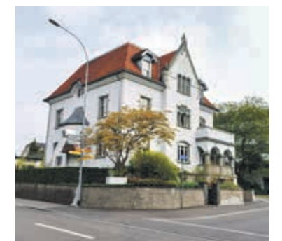
Das Ingenieurbüro Näf & Partner mit Hauptsitz an der Rebenstrasse in Arbon.
