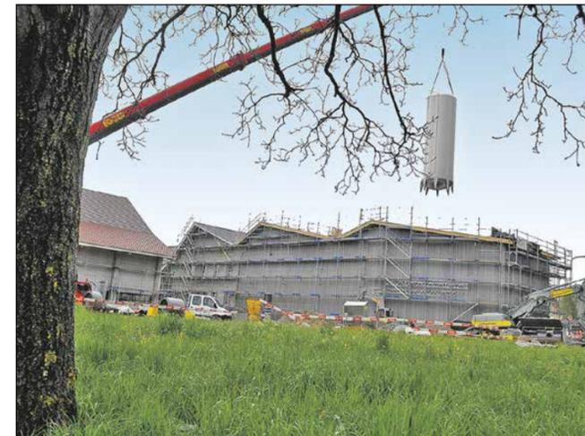
Per Kran werden die aus Stuttgart angelieferten Süssmost-Tanks in den neuen Tankkeller gehievt.
