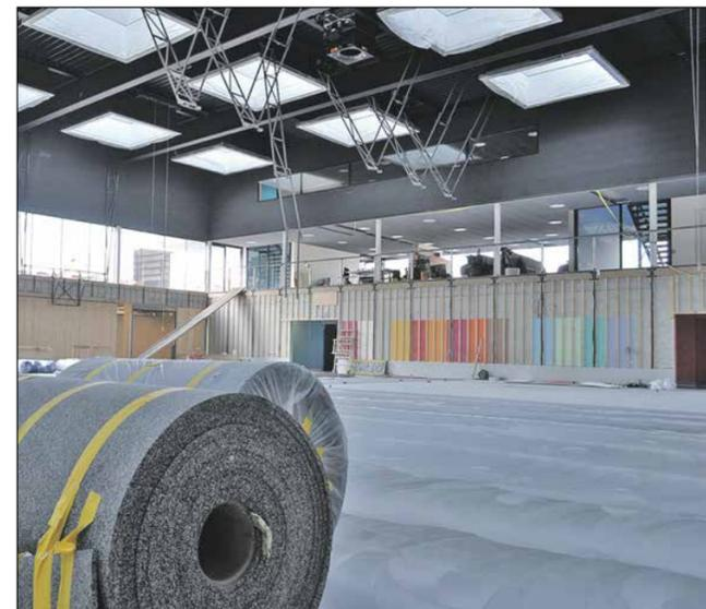
Der Betonboden in der neuen Sporthalle ist erfolgreich abgedichtet worden. Als nächstes werden die Unterlagsböden eingebaut.
