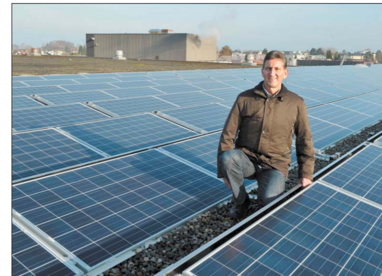
Betriebsleiter Josef Müller auf dem Dach der Produktionshalle der Firma Hügli inmitten der Photovoltaikanlage mit 384 Modulen.
