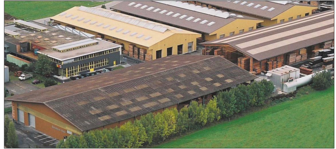
Zurzeit wird auf den Dächern der Banderet AG in Arbon eine Gross-Photovoltaik-Anlage erstellt.
