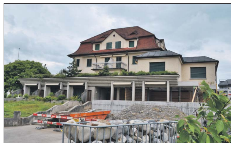
Derzeit wird das Bürgerheim Bergfrieden umfassend renoviert.
