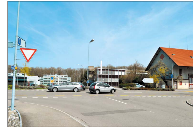
Ende November soll der Kreisel Romanshorn- / Rütistrasse fertig sein.
