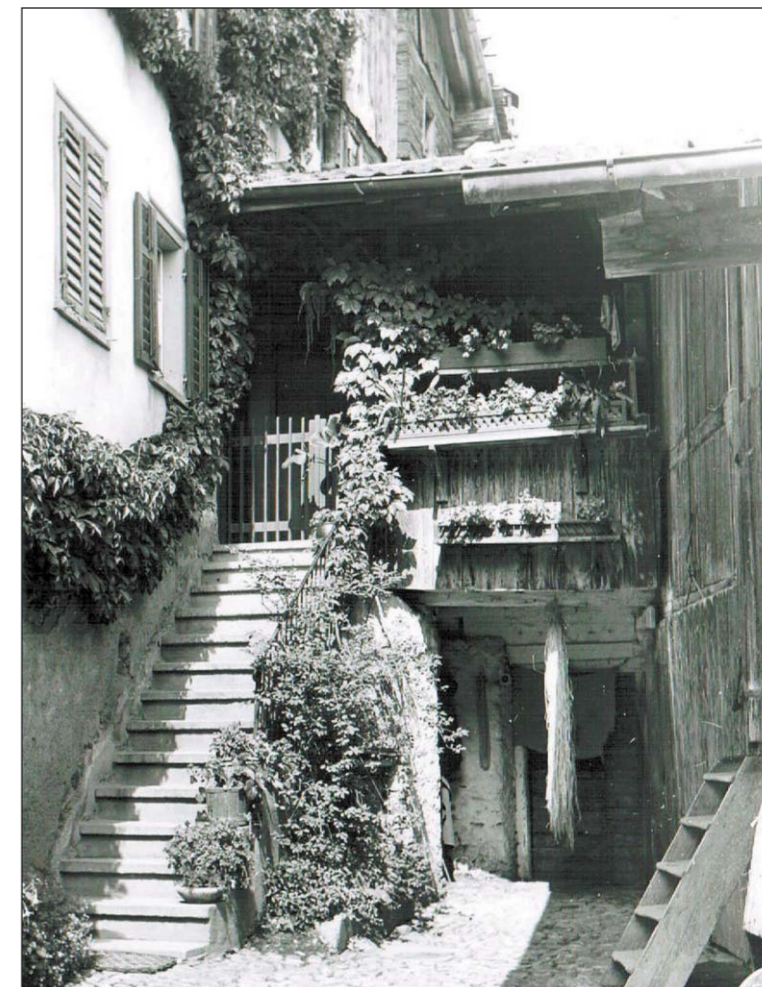
Das Turmhaus an der Freiheitsgasse an der Arboner Stadtmauer mit Details von der Südseite stand einst in einem dicht bebauten Quartier.
