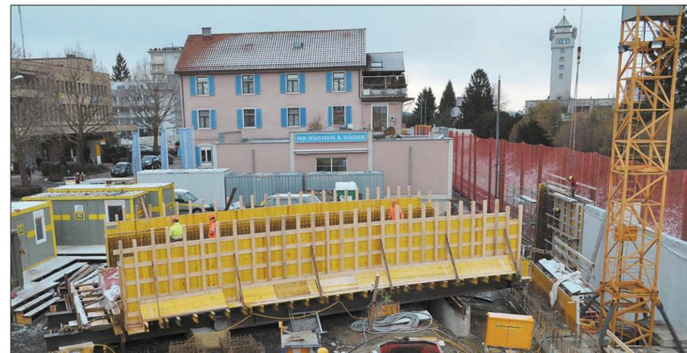
Die fünf Meter breite Brücke Rebenstrasse wird derzeit auf «Festland» gebaut – nach einer Aushärtungszeit von vier Wochen soll sie Mitte März mit einem Spezialkran nachts auf die vorbereiteten Widerlager versetzt werden.
