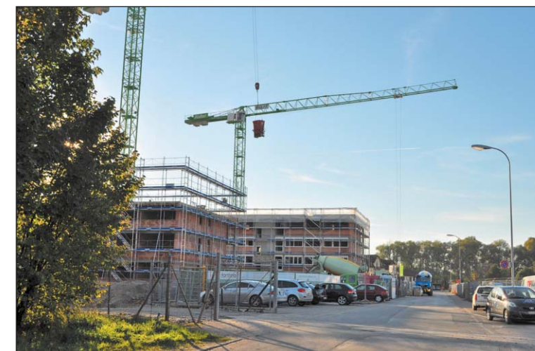
Der westliche Teil der Schöntalstrasse zwischen Ahornstrasse und Bifangstrasse in Steinach bedarf einer grundlegenden Sanierung.
