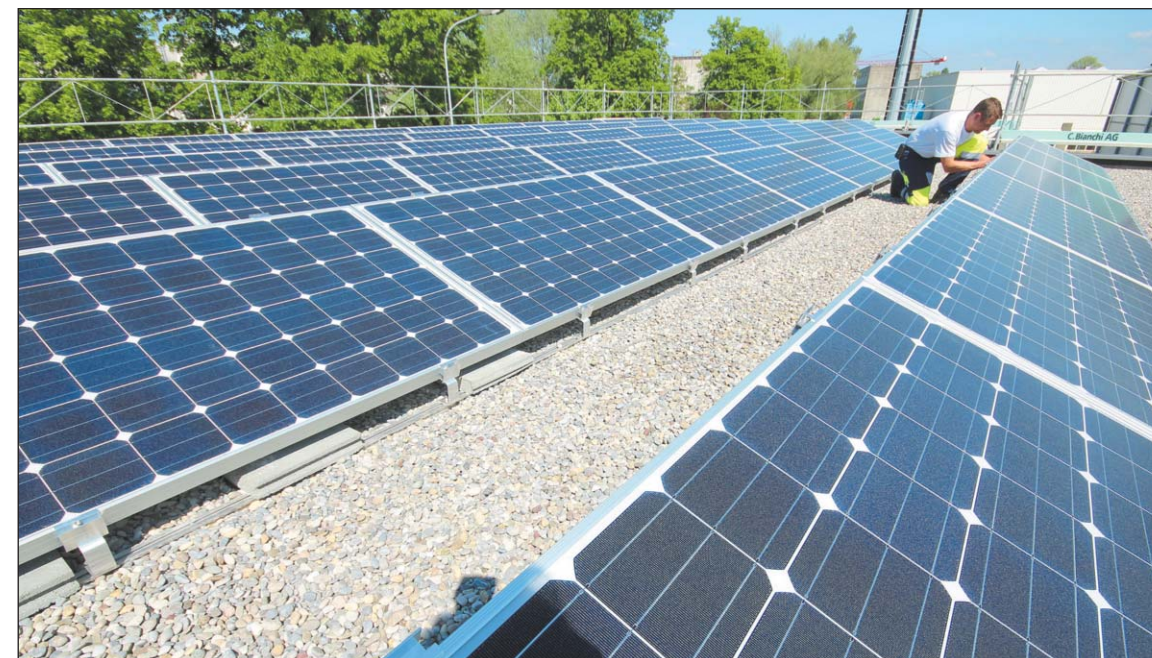
Mit der eigenen Photovoltaikanlage und neuer Regeltechnik erarbeitet die Arbon Energie AG die Grundlagen für die dezentrale Stromeinspeisung in das Niederspannungsnetz.
