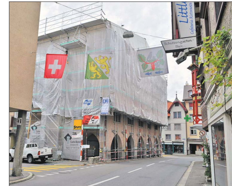
Das Dach des «Kappeli» ist wieder dicht, und das Notdach kann nächste Woche entfernt werden. Für den Abbruch wird die Schmiedgasse gesperrt.
