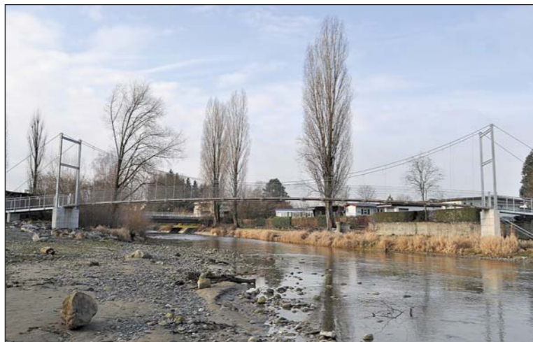
Für den Bau der neuen Fussgängerbrücke in Steinach sind Mehrkosten von 24 000 Franken entstanden.
