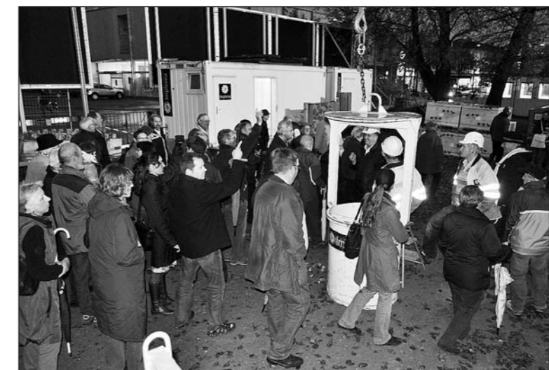
Zahlreiche Interessierte fanden sich auf Einladung von Implenia in der Zentrumsüberbauung «Rosengarten» zu einer Baustelleninformation ein.
