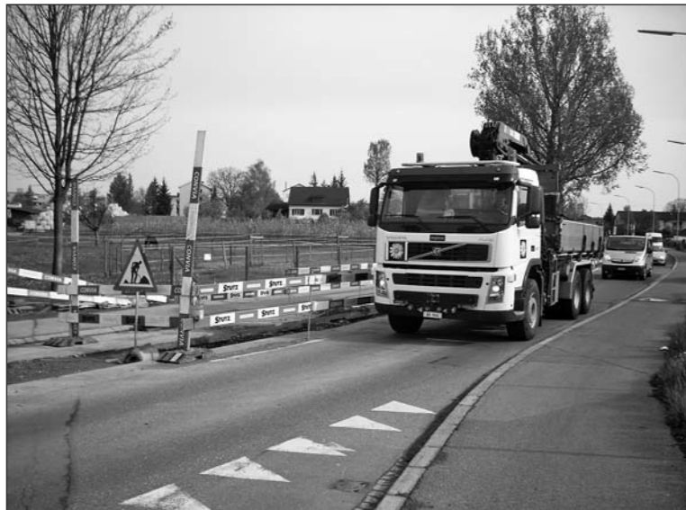
Zu Verzögerung der Bauarbeiten an der Landquartstrasse in Arbon kam es aus verschiedenen Gründen.
