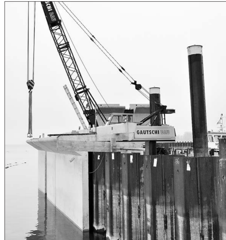
Mit einem Fugenabstand von zwei Zentimetern werden insgesamt 93 Betonelemente genau auf jeweils zwei Stempel der Spundwand gesetzt.
