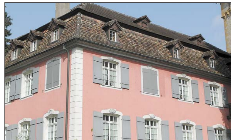
Dieses prächtige Leinwand-Handelshaus steht ausserhalb der Arboner Stadtmauern. Gedeckt ist das Rote Haus mit einem Walmdach, von dem der untere Teil, wie beim Rathausdach, abgesetzt, leicht geschwungen und nach dem Vorbild des Königsschlusses in Versailles mit Mansarden ausgestattet ist.
