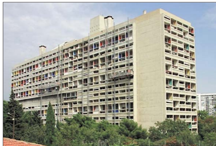
Grundidee (1907): «Wohnmaschine» wie Ozeandampfer, 200 doppelgeschossige Maisonetten für 800 Menschen in 24 x 70 x 140 Meter. Die Licht-Luft-Leben-Idee verlangte Kuben (raumsparend auf Grundpfeilern) mit (Garten auf) Flachdach, helle sichtbetonierte Fassaden, Fensterbänder mit Sonnenblenden. Der moderne Baustil entstand um 1920 in Dessau und wurde bis um 1980 weltweit gepflegt.
