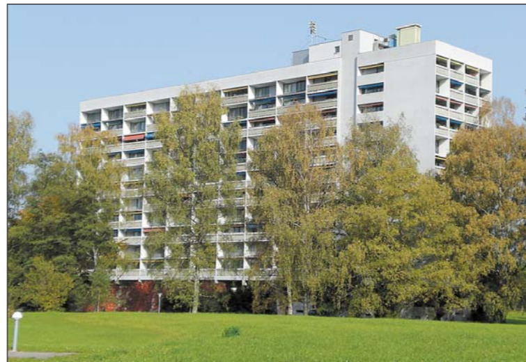
Eines von ursprünglich zwei in Arbon geplanten Grosswohnhäusern auf Stelzen (und fundiert auf 34 Betonpfählen), nach dem Vorbild der «Unité d'habitation»: zwölf Stockwerke, 95 Wohnungen, davon 63 zweistöckige 4 1/2-Zimmer-«Villen» mit Loggien zu monatlich 170 Franken; Wendelnot-treppe. Grundfläche verkehrsoffen. Das zweite Haus hätte nordöstlich die Brühlstrasse überspannen sollen. 1994 wurden die 4 1/2- in 3 1/2-Zimmer-Wohnungen umgewandelt.
