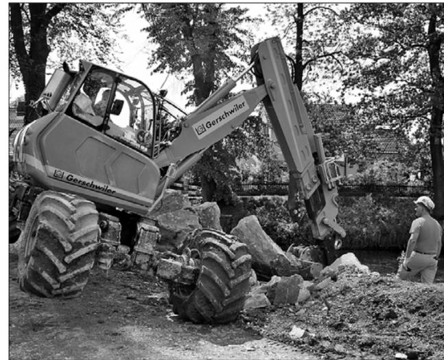
Für den Steinverbau eignet sich dieser Schreitbagger mit Greifer, der durch das Gewicht der Bollensteine manchmal arg in Schräglage gerät.
