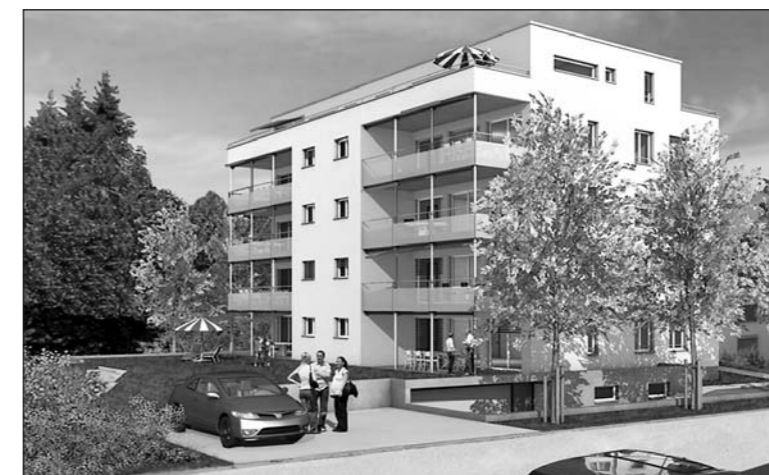
Mit dem Bau des Mehrfamilienhauses wird im kommenden Frühjahr begonnen. Die Eigentumswohnungen sind im Sommer 2010 bezugsbereit.
