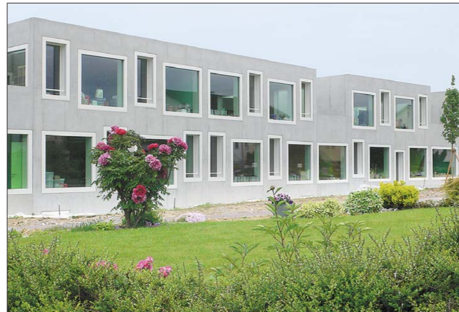
Das konstruktive Konzept des neuen Steinacher Primarschulhauses trägt der angestrebten Architektur, den gewünschten Raumstimmungen und der hohen Nutzungsflexibilität Rechnung. Das Haus ist in Sichtbetonweise konstruiert.
