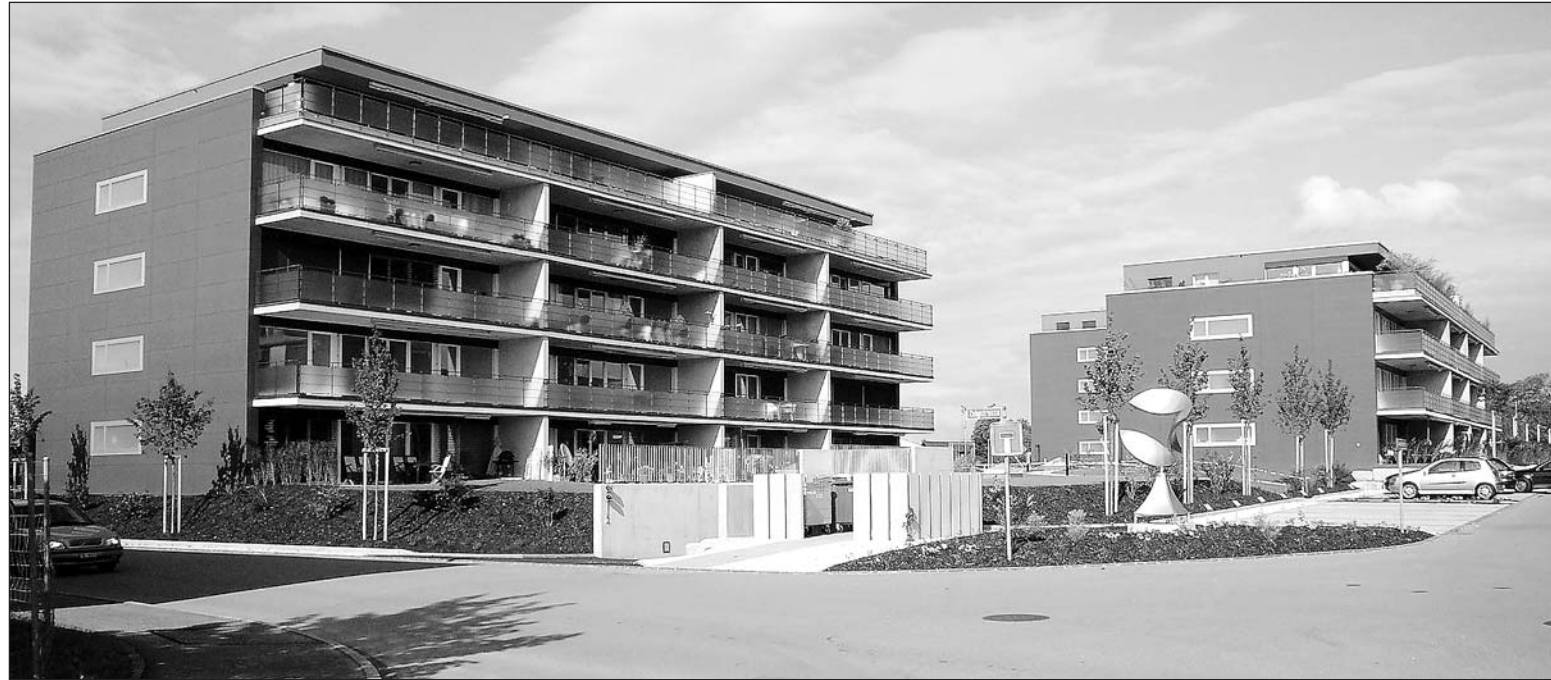
Überbauung Seefeld in Kreuzlingen: Über 300 moderne Fenster des Goldacher Unternehmens Aerni Fenster helfen Energie sparen.
