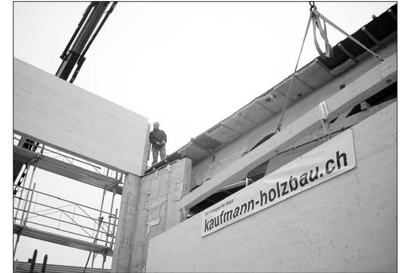
Mit der Montage der Trag- und Dachkonstruktion wurde der Rohbau des Bühnenanbaus Mehrzweckhalle Freidorf abgeschlossen.
