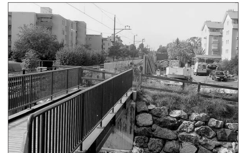
In den nächsten vier Wochen lassen sich Nacharbeiten für den Bau der neuen SBB-Haltestelle in Steinach nicht vermeiden.
