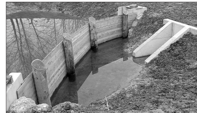
Die fünf Rückhaltebecken beim A1-Zubringer in Arbon werden so umgebaut, dass sie den heutigen Anforderungen des Umweltschutzes genügen.
