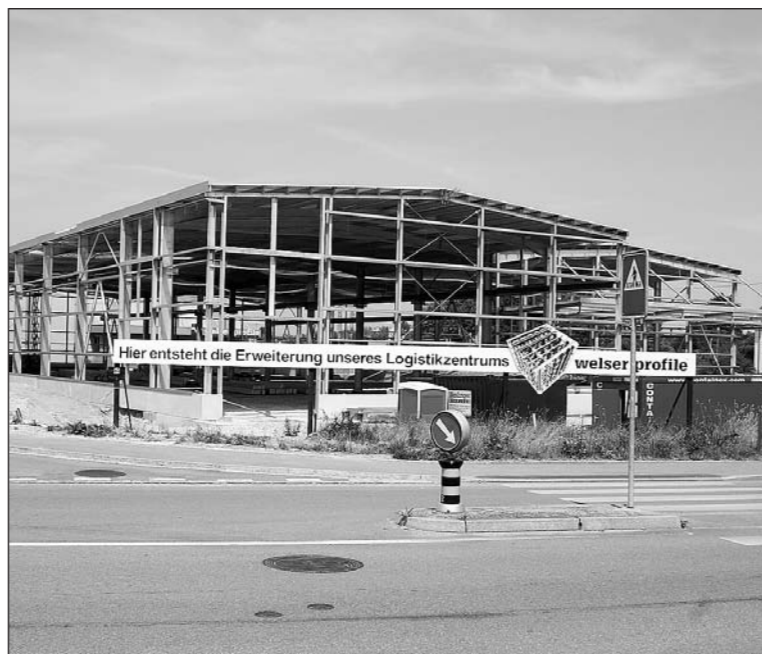
Der Ausbau des Logistikzentrums von Welscher AG, Stahl- und Metallprofile, in Horn geht rasch und planmässig voran.
